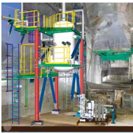
Anlagenscan mit 3D-Modell-Kondensatsammelbehälter.
