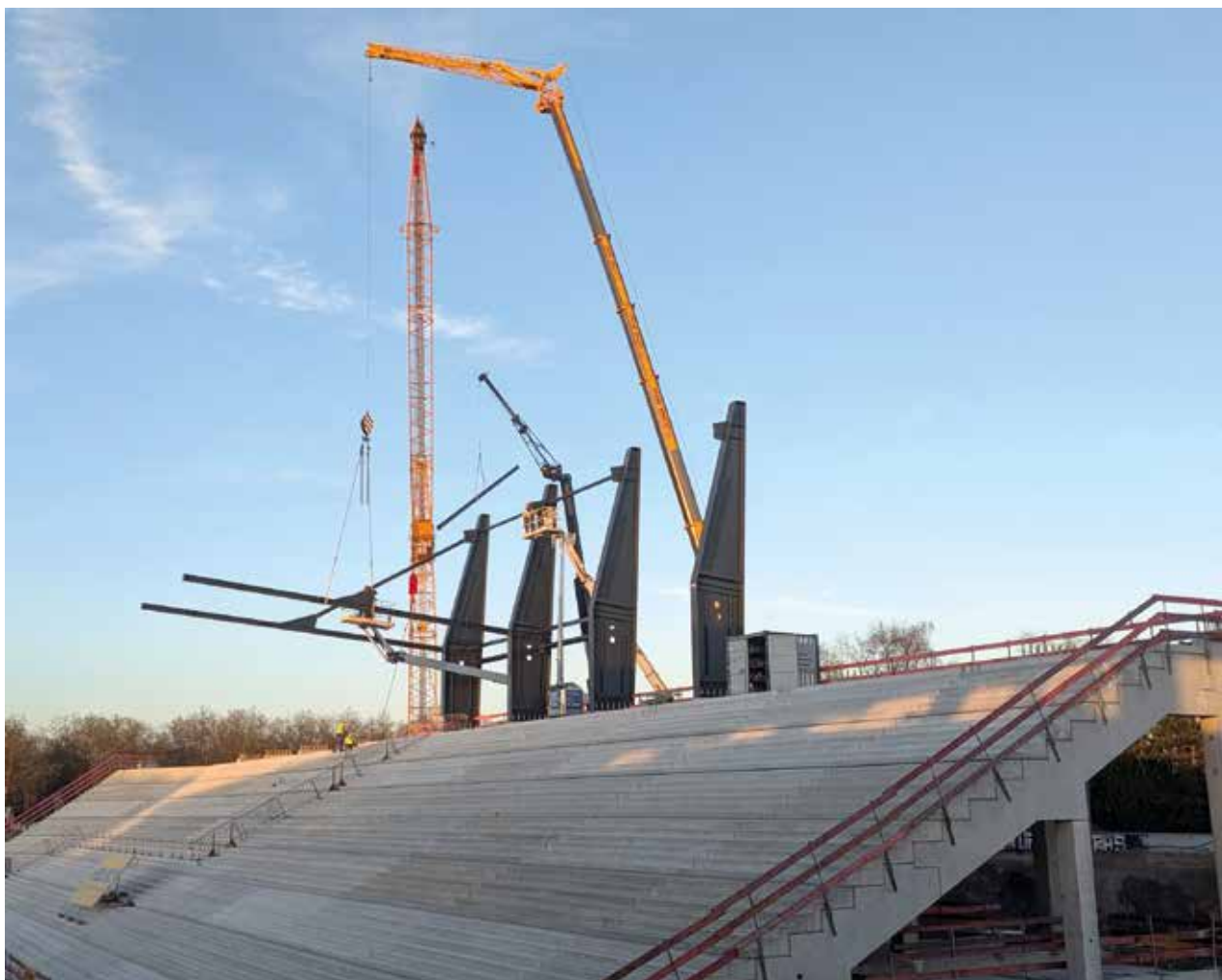
Montage der Dachkonstruktion der Osttribüne des Preußenstadions.
