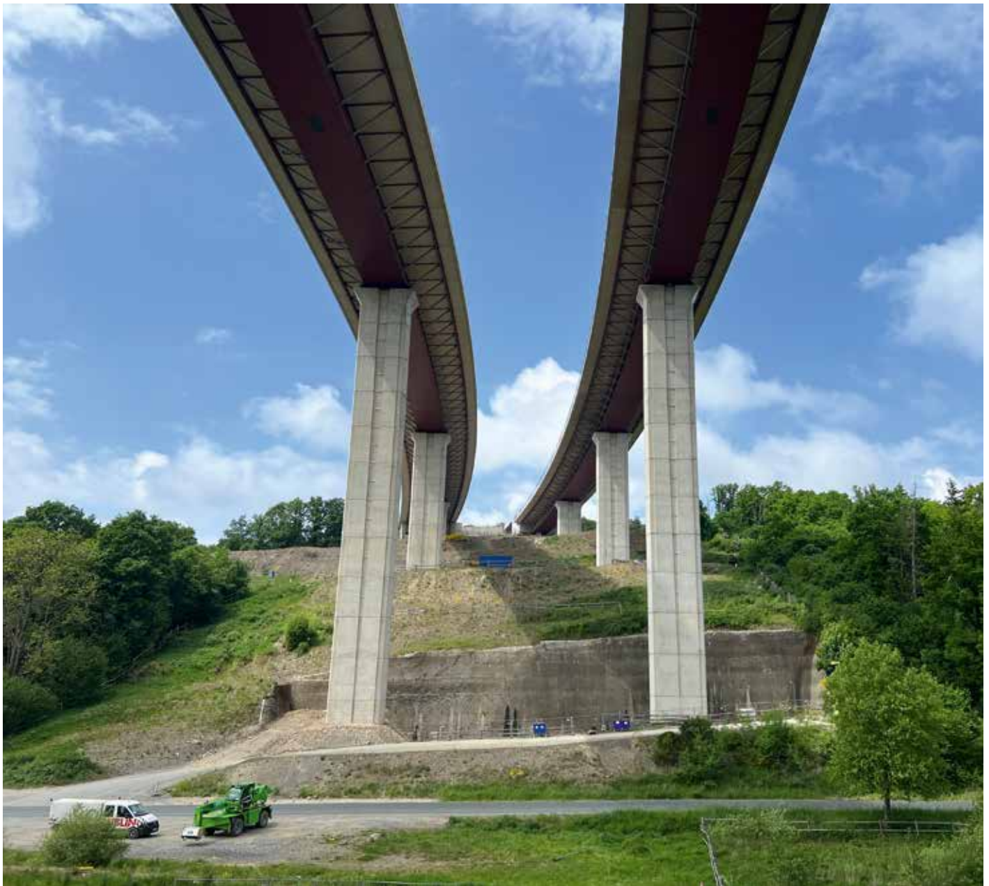
Rechte Teilbrücke mit einer Länge von 480 Meter wird um ca. 20 Meter zur linken Teilbrücke hin verschoben.
