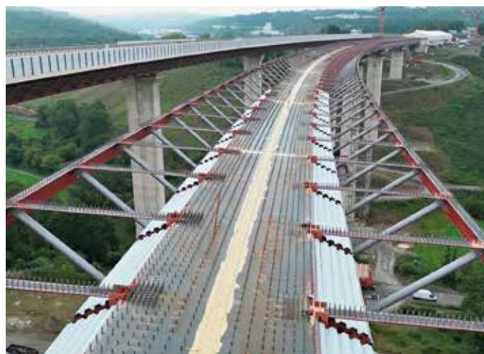
Aufbau der Stahlkonstruktion. Auch zu sehen die Verankerungspunkte für die aufzubringende Betonfahrbahn.
