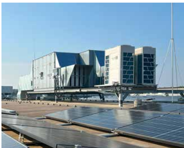
Synergie auf dem Dach: Moderne Lüftungsanlagen (AHUs) mit integrierten Hisense VRF-Außengeräten, umgeben von einer leistungsstarken PV-Anlage.
