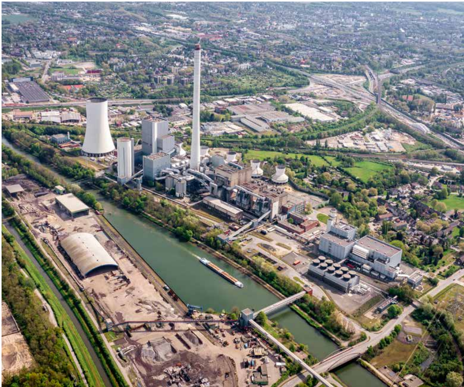
Das Kraftwerk Herne von oben. Die GuD Anlage ist unten rechts im Bild.
