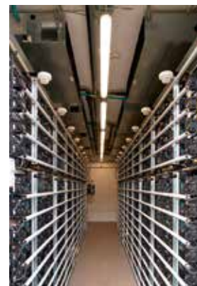
Ein bestückter Container, an der Decke die VRF-Kanalgeräte von Panasonic.
