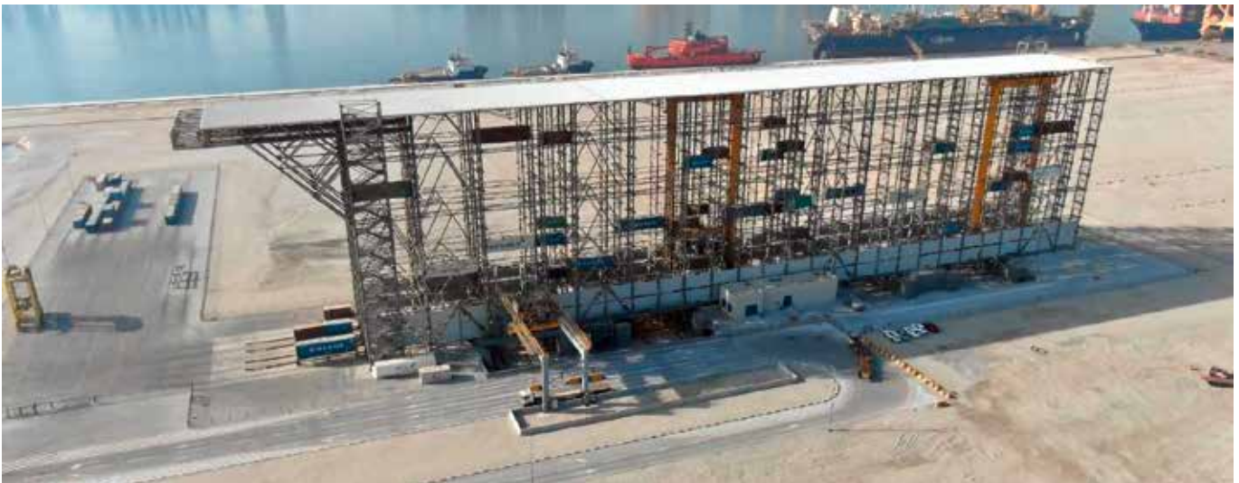
Knowhow aus der Stahllogistik optimiert den Hafenbetrieb. Modell des automatisierten Hochregallagers am Containerumschlagplatz von Boxbay in Dubai.
