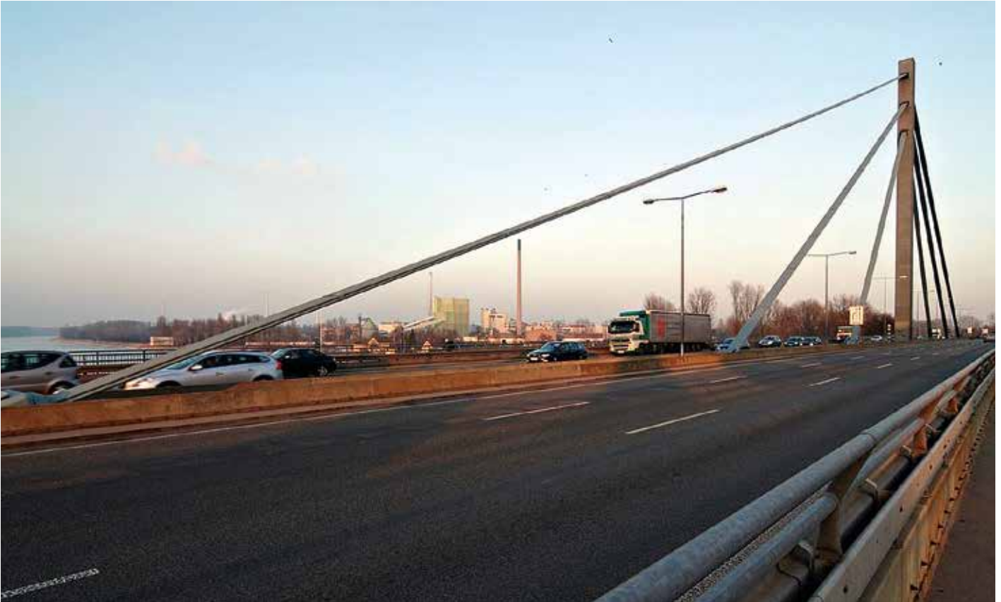
Die Sanierung und Ertüchtigung der Rheinbrücke begleiten Ingenieure des KIT wissenschaftlich. Seit 1966 führt die 292 Meter lange Schrägseilbrücke die Bundesstraße 10 über den Rhein und verbindet Karlsruhe mit Wörth.
