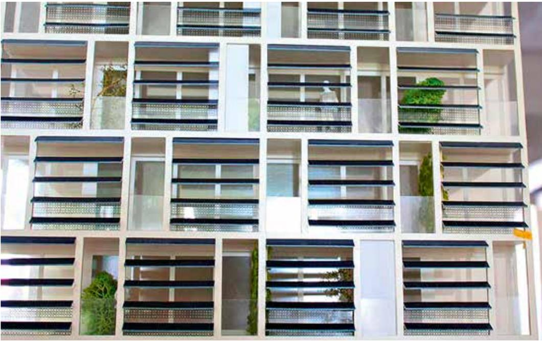
Der Smart Green Tower erhält eine Gebäudehülle aus Glas/Glas-Photovoltaik-Modulen mit Perc-Zellen.
