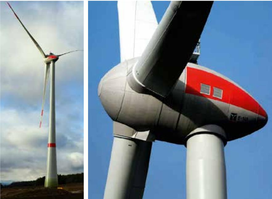
ENERCON-Anlagen lassen sich optisch leicht von den Anlagen anderer Hersteller unterscheiden. Die Maschinenhäuser (Gondeln) der Anlagen sind seit Baujahr 1995/96 tropfenförmig. Das Design dieser auffallenden Gondeln wurde vom britischen Architekten Norman Foster entwickelt. Im Bild eine Anlage E-141 4,2 MW.
