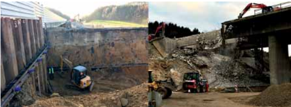
Rückverankerung der Gegenrichtung und Abbruch in Fahrtrichtung Münster.
