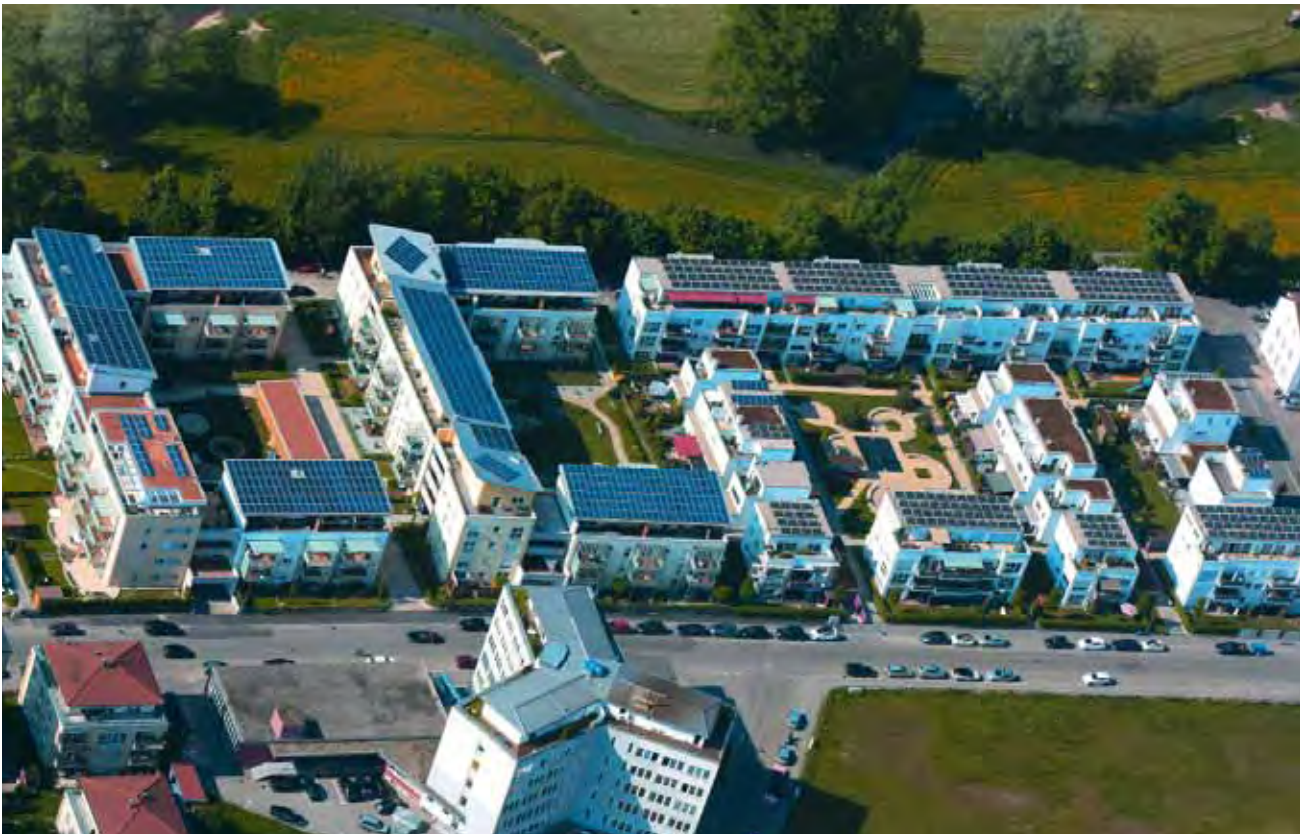
Die Plusenergie-Siedlung Landstuhl besteht aus 13 Ein- und Zweifamilienhäuser sowie acht Mehrfamilienhäusern. Große Teile der Dächer sind mit Photovoltaikanlagen bestückt. Foto: Ludmilla-Wohnpark GmbH
