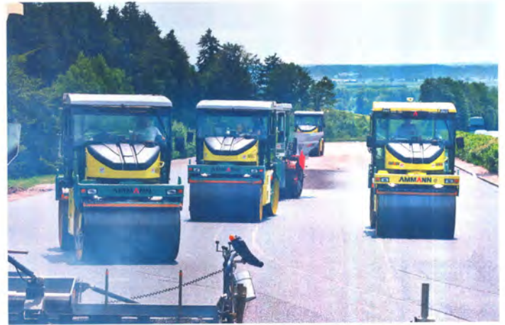
Asphaltbau stellt hohe Ansprüche an die Logistik einer Baustelle Bild: Ammann Schweiz AG
