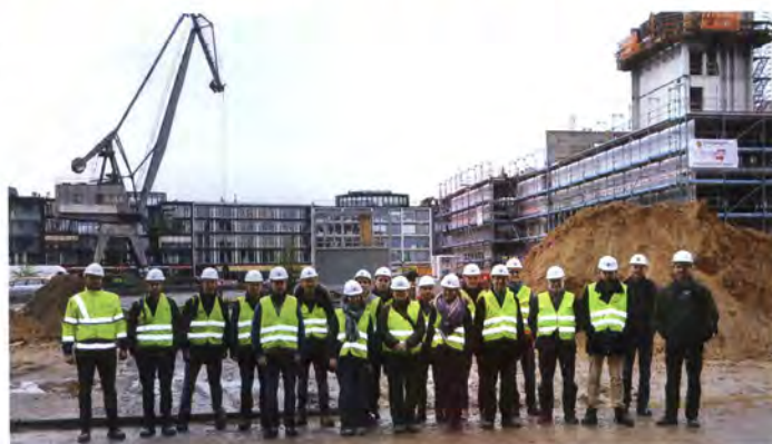
Im Hintergrund rechts ist der Rohbau des Bürogebäudes und der in Kletterschalung vorseilende Treppenhaukern zu sehen, im Vordergrund die Teilnehmer der Exkursion
