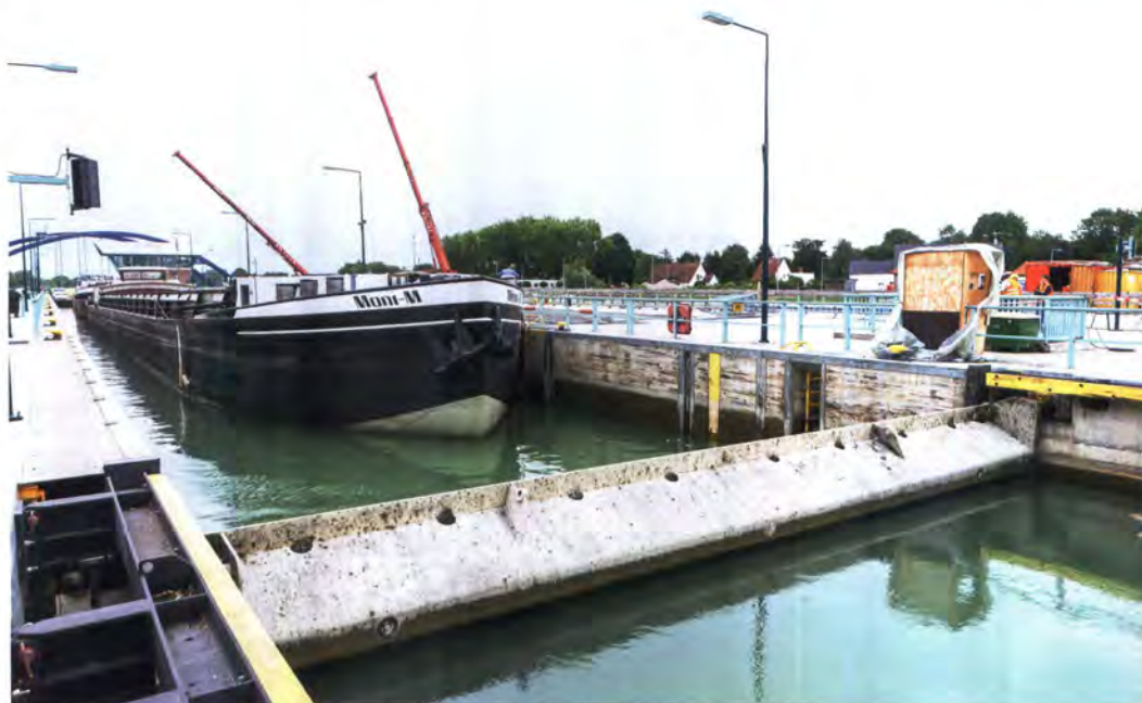
Elektrohydraulische Antriebe öffnen und schließen die Klapp- und Stemmtore, die acht Umlaufverschlüsse in den Längskanälen und die zwei Querverschlüsse der Zwillingschleuse in Münster Bild: Bosch Rexroth AG
