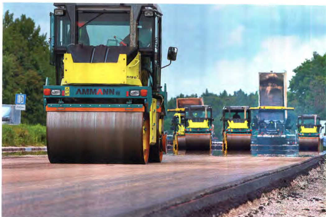
Wissenschaftler forschen an den Prozessen für die Verbesserung an Autobahn-Baustellen Bild: Ammann Schweiz AG
