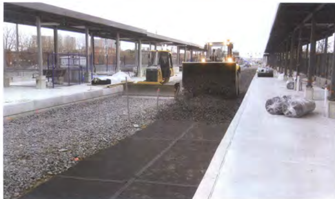
Die elastischen Unterschottermatten erreichen den geforderten Erschütterungsschutz bereits mit einer einzigen Schicht.
