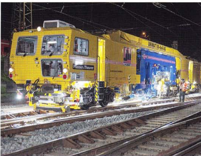
Mit der vollständigen Unterstopfung einer Weiche wird eine nachhaltige Lagestabilität erreicht
