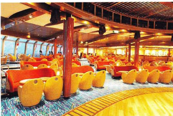
Theatrium eines Kreuzfahrtschiffes mit gelochten Decken und Deckenschwertern
