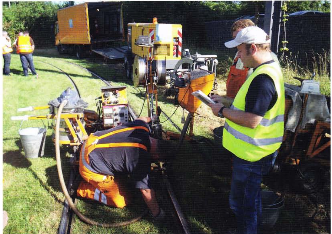
Bild 3: Unter-Pulver Auftragschweißung von Rillenschienen
