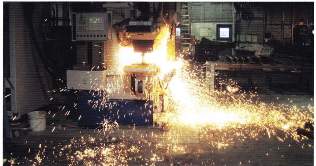
Bild 1: Abbrennstumpfschweißung im Schweißwerk
