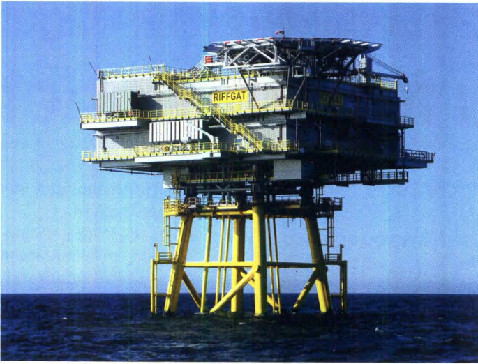
Das Umspannwerk verfügt über drei Ebenen, auf denen die elektrotechnischen Einrichtungen, die Sicherheitstechnik und ein Hubschrauberlandeplatz untergebracht sind Foto: Matthias Ibeler/EWE AG
