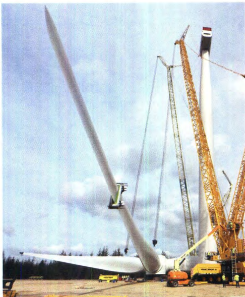
Im Oktober letzten Jahres hat Siemens Energy den Testbetrieb mit den bisher weltweit längsten Blades aufgenommen. Die 75 Meter langen Blätter haben ein spezielles Profil Bild Siemens
