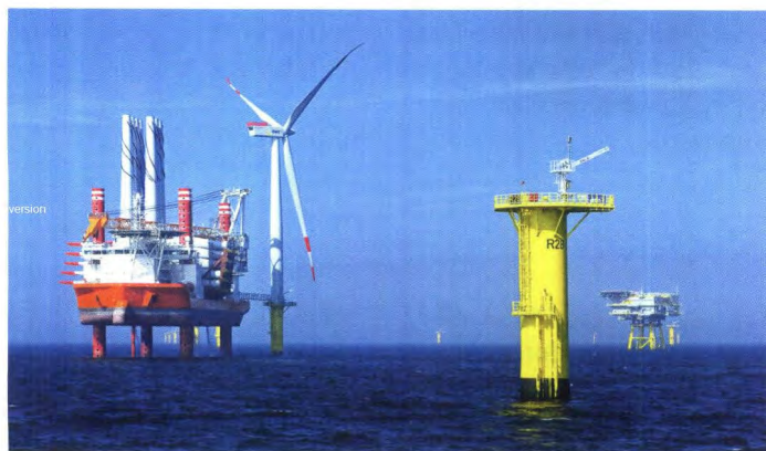
Die Windkraftanlagen haben eine Leistung von je 3,6 Megawatt bei einem Rotordurchmesser von 120 Metern Foto: Matthias Ibeler/EWE AG
