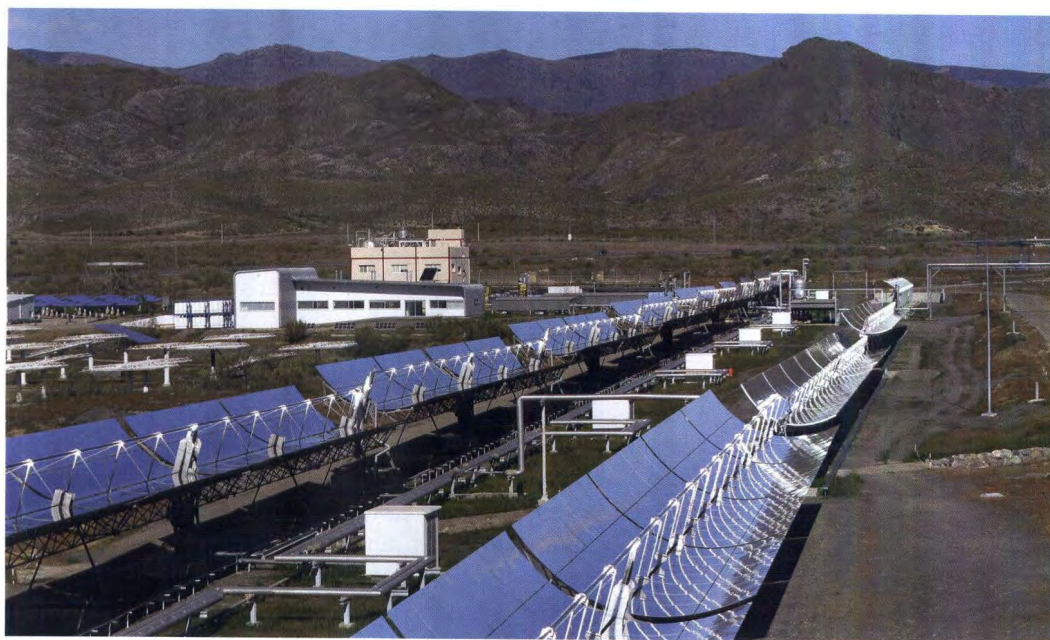
In der Solar-Testanlage wird der Wasserdampf, der die Turbine antreibt, direkt im Receiverrohr erzeugt
