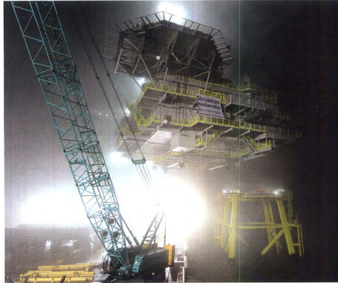
Der Kran des Spezialschiffes setzt das Umspannwerk punktgenau auf der Jacket-Unterkonstruktion ab Foto: Matthias Ibeler/EWE AG
