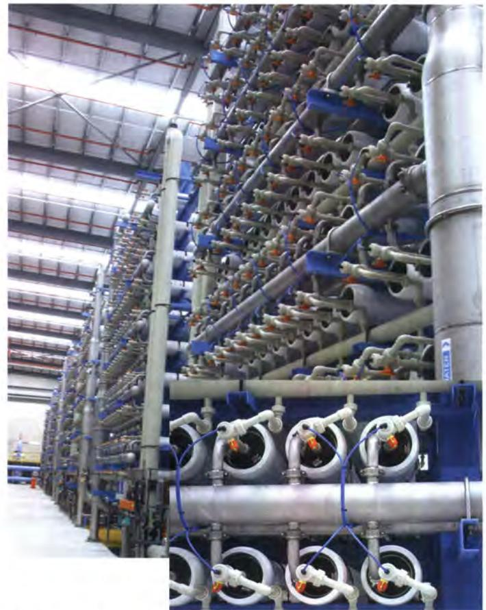
**Bild 3:** Der 3-Wege-Kugelhahn mit Positionsbegrenzung 180° in der Entsalzungsanlage der Southern Seawater Desalination Plant, Perth, Australien
