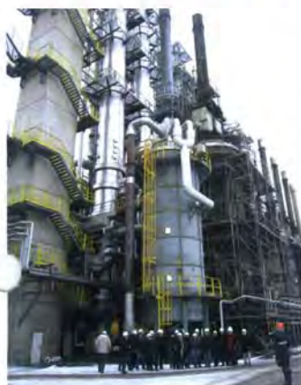
Vor der weltgrößten kontinuierlichen Teerdestillation
