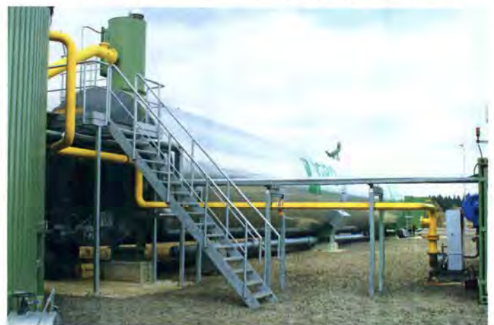
Bild 2: Der liegende Fermenter ermöglicht eine schnellere und effektivere Vergärung als voll durchmischte Systeme
