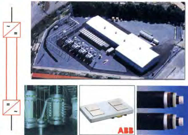
Bild 6: Gleichstromübertragung mit Spannungsumrichtern und Polymer-Kabeln (HVDC Light™)
