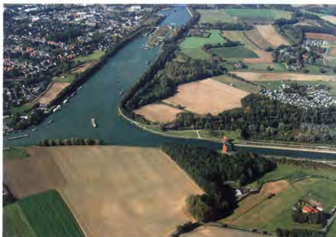
Bild 1: Für den Transport von Massengütern sind Wasserstraßen der optimale Transportweg.
