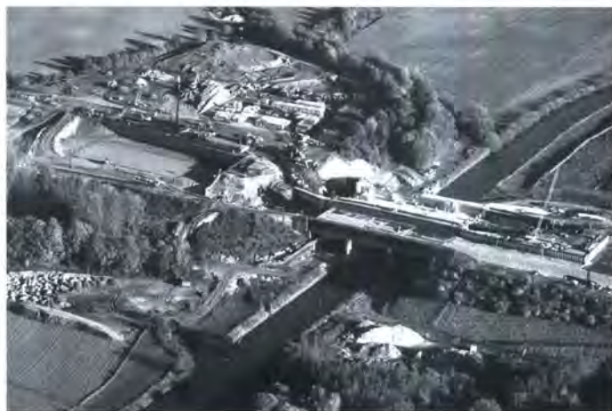
Bild 4: Die bis zu einer Tiefe von 10 m beschädigte Kanalsohle ist hier schon wieder repariert.
