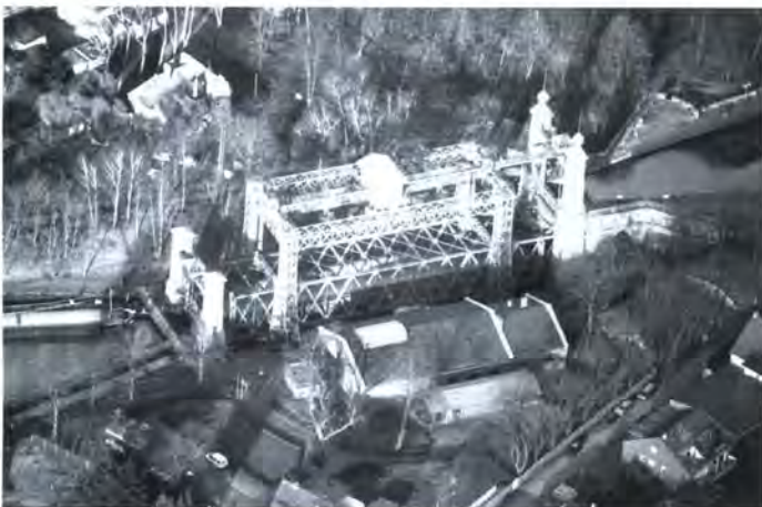
Bild 1: Als Kaiser Wilhelm II. das Henrichenburg Schiffs-Hebewerk in Betrieb nahm, war es das erste und größte Schwimmer-Hebewerk seiner Zeit.
