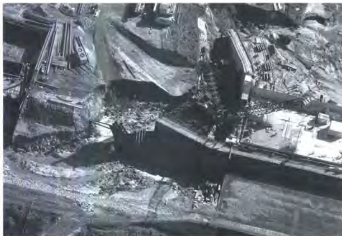
Bild 3: Die Dammbruchstelle am Dortmund-Ems-Kanal bei Olfen Fotos: N. Piontek
