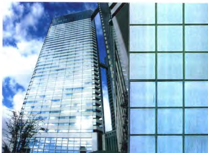
Gebäude in Tokyo mit verflaster Fassade, die teilweise fotokatalytisch beschichtet ist. Bild: INM
