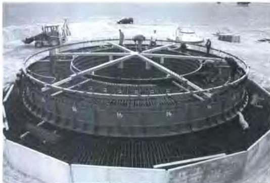
**Bild 2:** Das Turmfundament im eingeschalteten Zustand. Vor dem Betonieren werden letzte Bewehrungsarbeiten ausgeführt.
