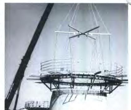
**Bild 3:** Das Außengerüst wird am Kopf des vorhergehenden Betonierabschnitts positioniert
