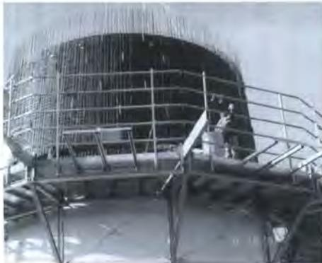
**Bild 4:** Die Innenschalung wird mit der am Boden eingebauten Bewehrung und allen Einbauteilen am Turmkopf montiert
