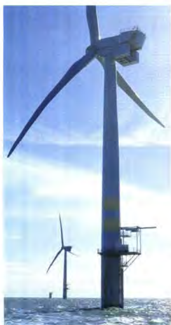
Die Arklow Bank vor der „üste Irlands - Standort der 3,6 MW Windenergieanlage Foto: GE Wind Energy
