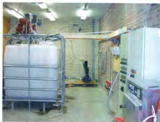
Bild 3: Die halbtechnischen Versuchsanlage in Betrieb
