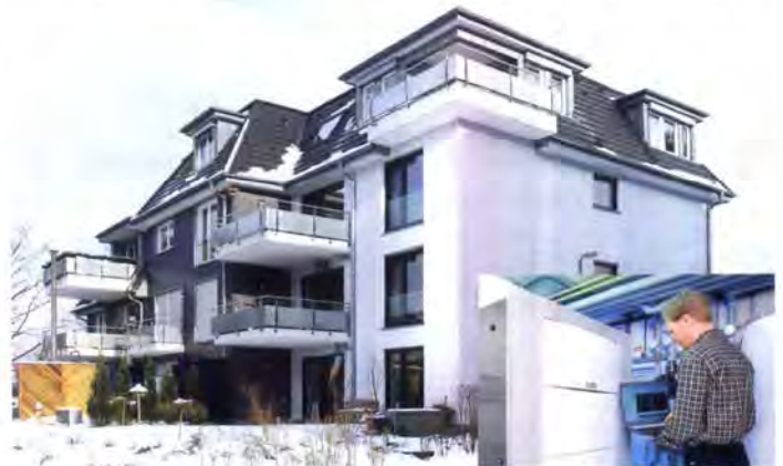
Seit Dezember 2002 erzeugen eine Brennstoffzellenheizung und ein Brennwärtegerät in diesem Haus mit 8 Wohnungen in Remscheid Strom und Wärme. Foto: Vaillant
