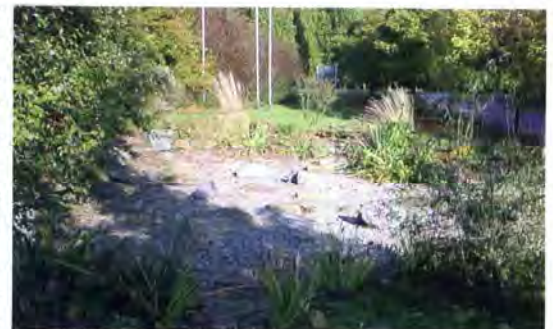
Versickerungseinrichtungen können als Teichanlagen aufwendig gestaltet werden.
