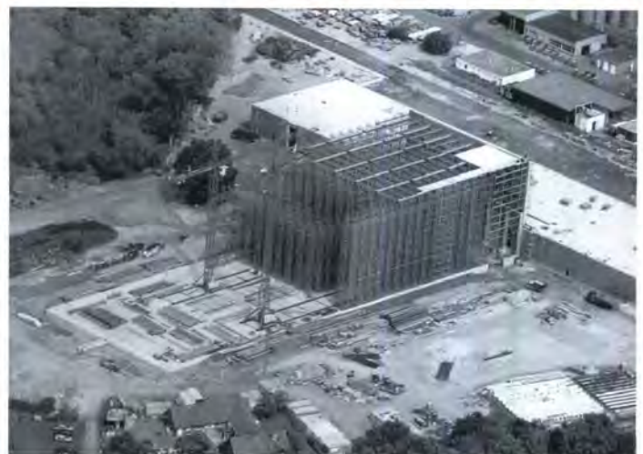
Innovative Konstruktionen werden heute von der Bautechnik verlangt.
