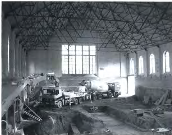
Bild 5: Um die Dachkonstruktion aus dem letzten Jahrhundert erhalten zu können, werden die leichten Solartec®-Module installiert.
