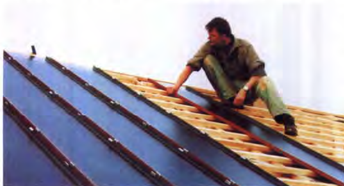
Bild 3: Die Elemente werden auf einer Lattenunterkonstruktion verlegt und über Steckverbindungen verkabelt.
