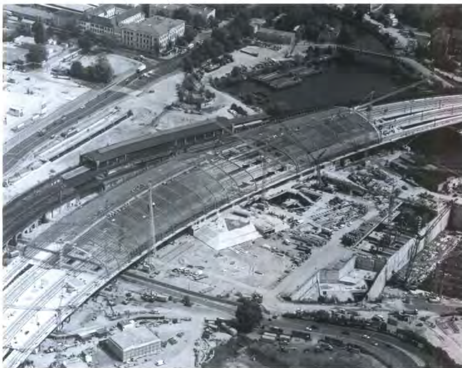
Die Baustelle „Hauptbahnhof - Lehrter Bahnhof“ mit dem Blick auf die mit einer Stahl - Glas - Konstruktion überdachte Bahnhofshalle
