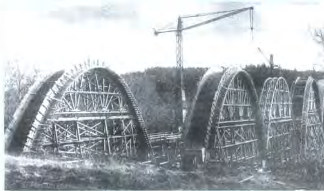
Einrüstung der Bogenrippen an der Rohrbachbrücke Stuttgart-Heilbronn, VDI-Z., 25.0.1939, S. 364
