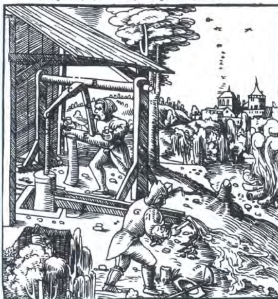
Bild 3: Ergonomische Gestaltung eines Pumpenschwengels, in: Agricola
