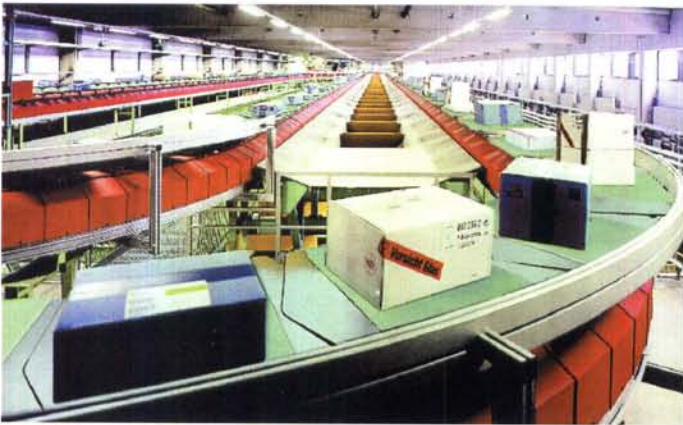
Auch in Sortiermaschinen wird die berührungslose Energieübertragung eingesetzt.
