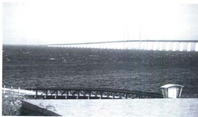
Bild 4: Öresundbrücke, Sicht von Malmö Foto: H. Herbst
