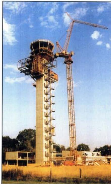
Für den Tower wurden 4000 m<sup>3</sup> Erde ausgehoben. Die Konstruktion enthält 3000 m<sup>3</sup> Beton, 325 t Beton Stahl und 140 t Stahl.
