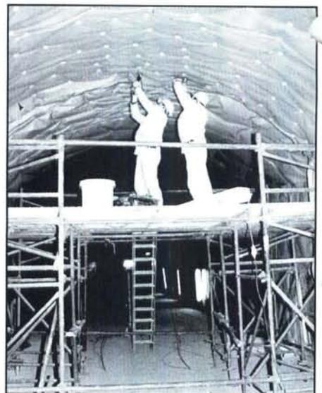
Bild 4 : Anbringen der Abdichtungsfolie Enka-drain mit Bolzenschubgerät.
