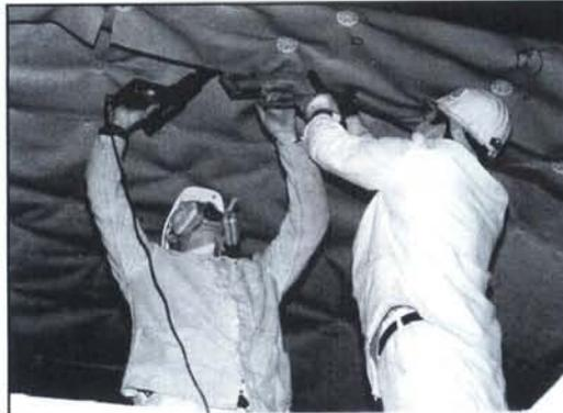
Bild 5: Die Abdichtungsfolie wird im Überlappungsbereich mit Hilfe von Heißluft verklebt.
