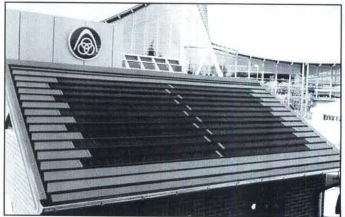
Bild 2: Für 1 kW Peak elektrischer Leistung müssen auf einer südorientierten Dachfläche rund 20 m² Solar-Elemente montiert werden.
