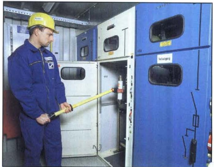
Bild 2: Mittelspannungsschaltanlage mit Trafoabgangsfeld 10 kV
