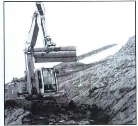
Auf den Deponiekörper wird als erstes eine 50 cm dicke mineralische Ausgleichsschicht aufgebracht.
