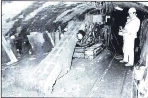
Bild 2 : Maschineller Vortrieb - Erste Schneidversuche mit der Teilschnittmaschine in der oberen Scheibe des Strebhohlraums.
