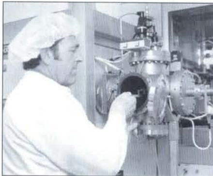
Im Ofen der Aufdampfanlage werden die Siliziumwafer mit dem gewünschten Material beschichtet.
