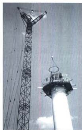
Im letzten Bauabschnitt wird das Maschinenhaus auf einen Stahlmast aufgesetzt.
