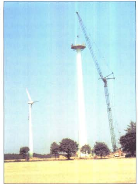
Die Windräder mit mehr als 90 m Höhe brauchen einen massiven Stahlbetonturm. Foto: Oevermann, Münster
