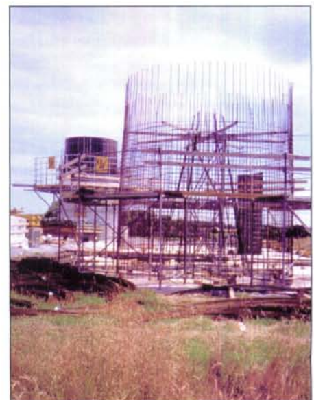
Die Schalung wird am Boden angefertigt. Foto: L. Jandel
