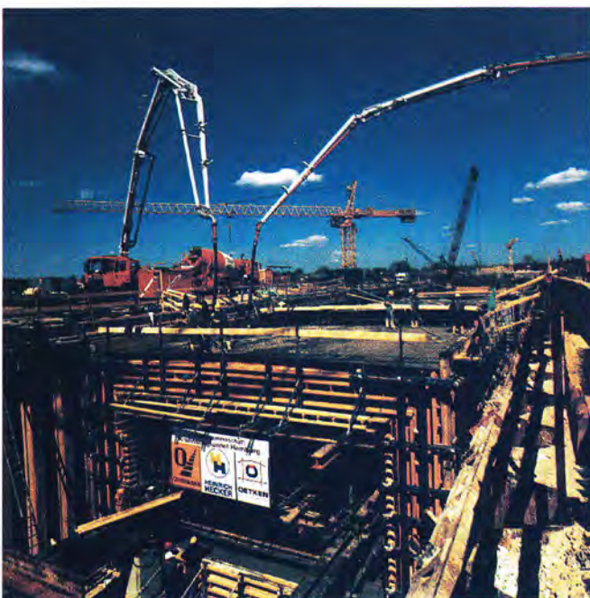
Zwischen den Spundwänden wird die Tunnelröhre hergestellt. Foto: Oevermann
