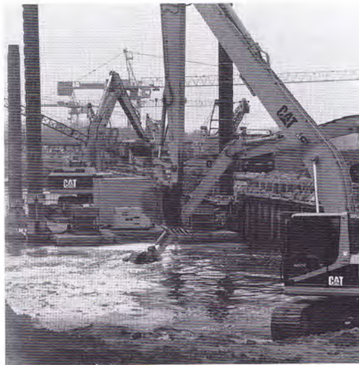
Der Boden wurde unter Wasser bis zur Sohle ausgehoben. Foto: Oevermann
